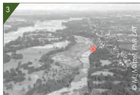
3 - Vue aérienne du site d'intervention.
