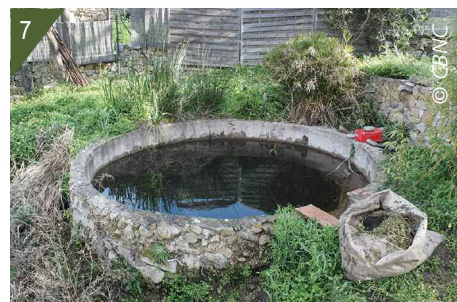
7 - Le bassin de Lumiu après intervention
