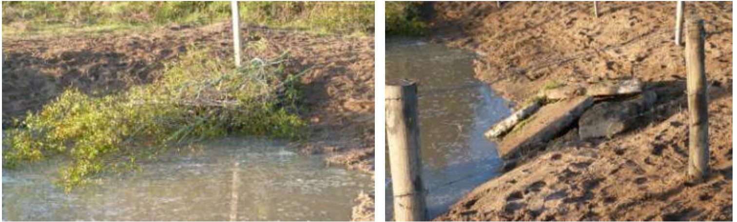
Figure 9 : Aménagement de la mare : rameaux de saules (à gauche) et bocailles (à droite)
